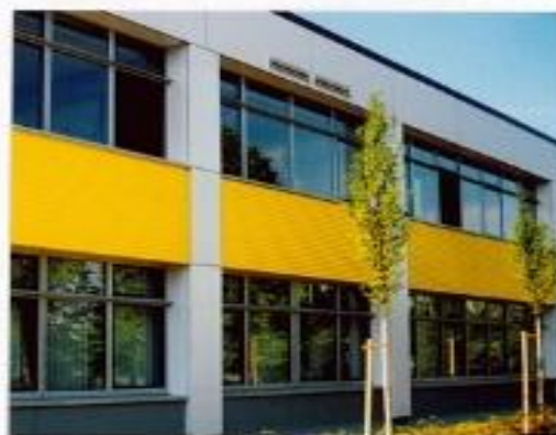
gelbes Wellblech strukturiert die Fassade, wirkt fröhlich
