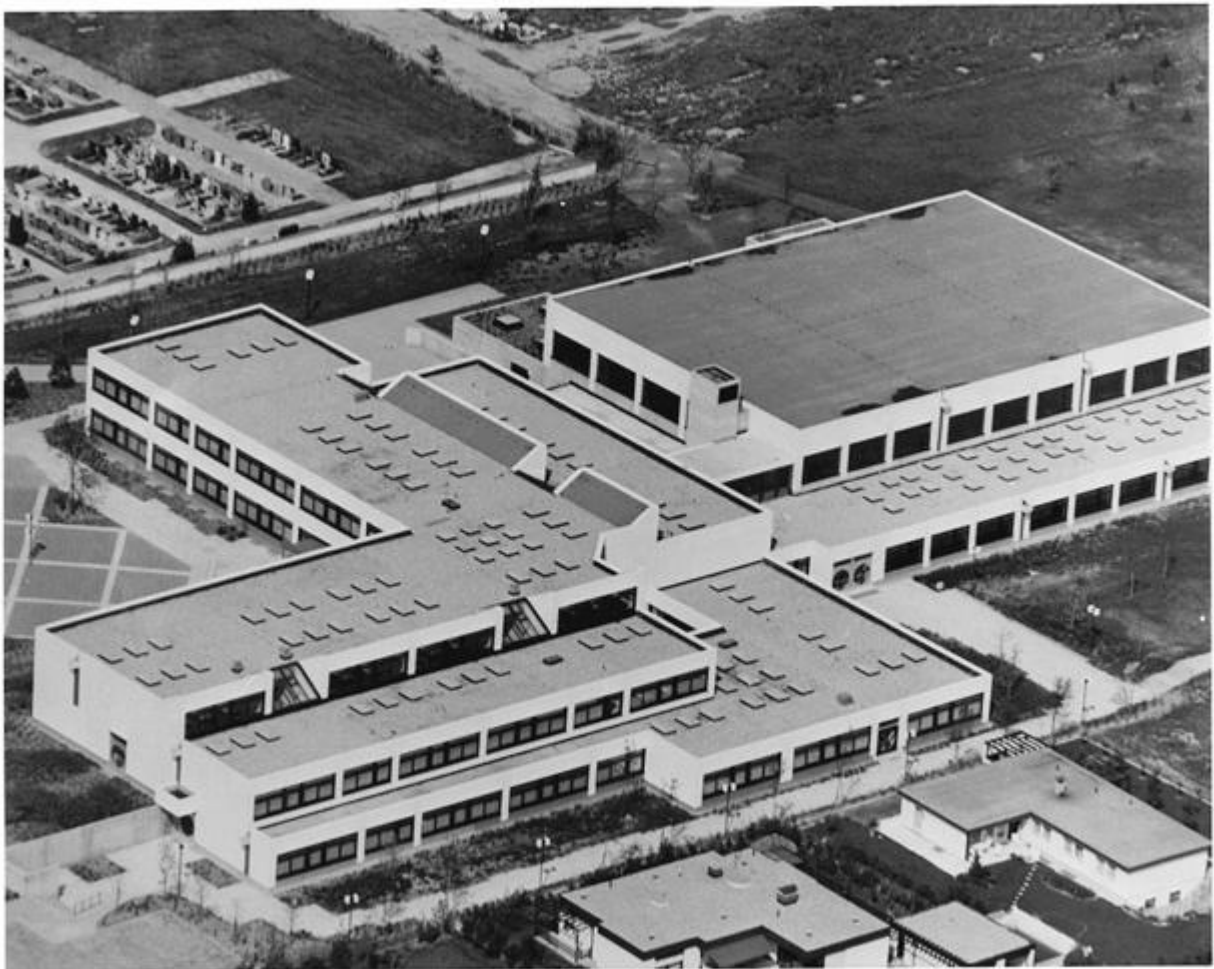
Unsere neue Hauptschule aus der Vogelperspektive - fotografiert unmittelbar nach Fertigstellung und Bezug im Jahr 1975 linke Bildhälfte: der Trakt der Klassenzimmer, Fachräume und Verwaltung in L-Form / rechte Bildhälfte: die Dreifachturnhalle
