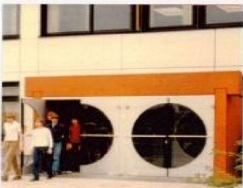
dominanter Betonklotz als Eingang im Stil der 70er Jahre
